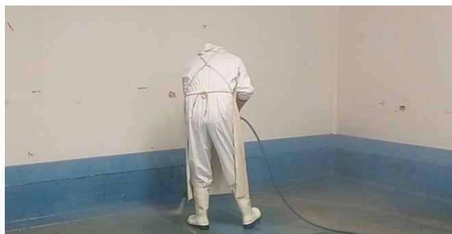
Figure 9 : Nettoyage d'une chambre froide avec nettoyeur haute pression (>81 dB(A))
